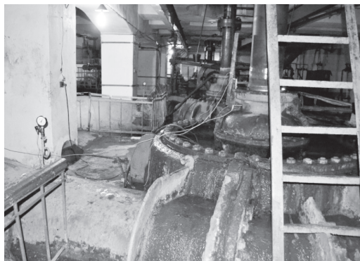
Рис. 10. Установлення вібродатчиків, датчика обертів і датчика тиску на насосі 1200В-6,3/100 НА № 1
